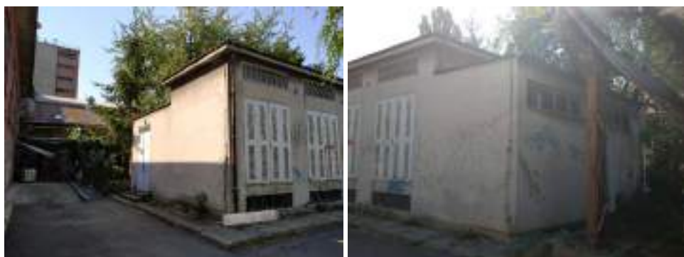
31 Pomoćni objekt - trafostanica
