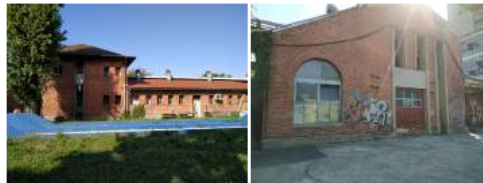
16 Kotlovnica, strojarnica, spremište, radionica, itd.
