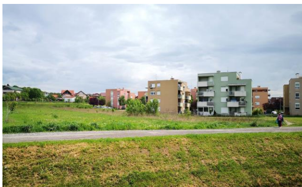
Slika 6. Nova izgradnja u Ulici Emanuela Vidovića
