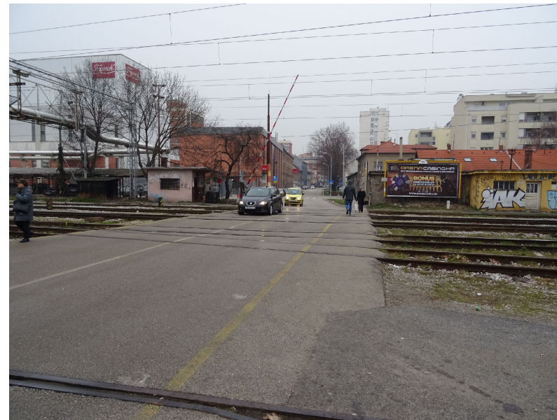
Željezničko - cestovni prijelaz Vodovodna - Magazinska
