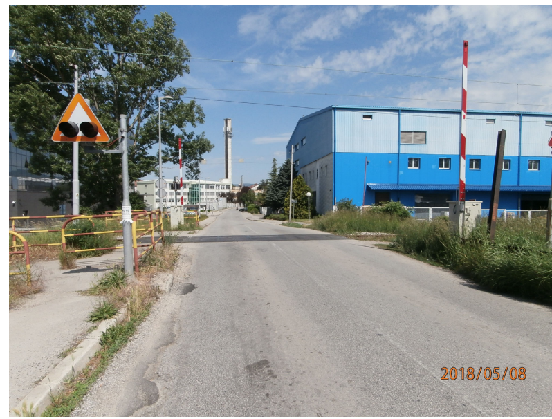
Željezničko - cestovni prijelaz, Sv. Klara Savski Gaj put XIII
