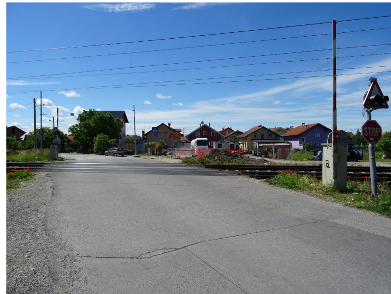
Željezničko - cestovni prijelaz Selnička ulica (Sesvetska Selnica)
