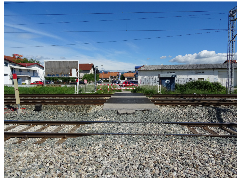
Pješački prijelaz Sopnička ulica
