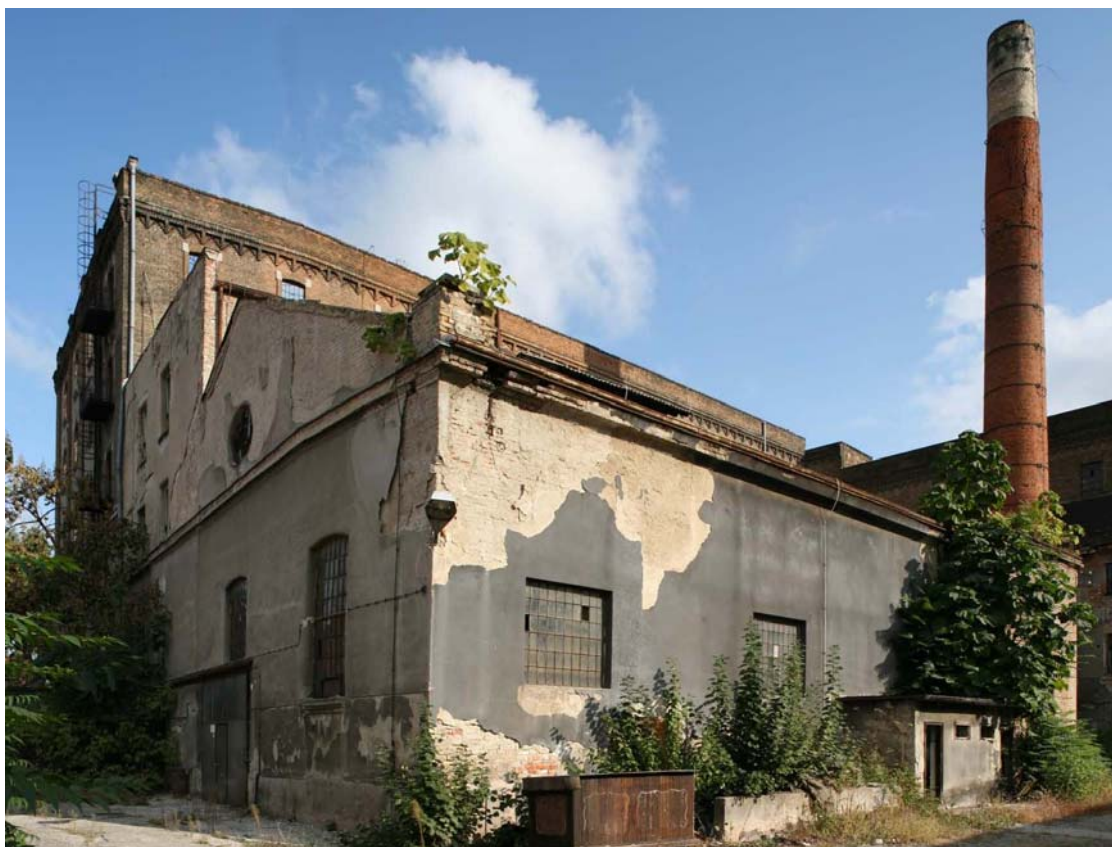
zgrada kotlovnice i dimnjak-pogled s juga
