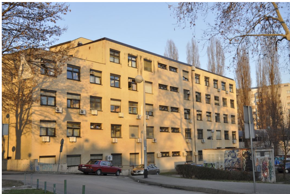
Slika 2.7. Lokacija zgrade u Prilazu baruna Filipovića na čijem je krovu instalirana mjerna postaja
