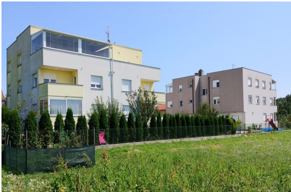
Recentna izgradnja uz sjeverni rub obuhvata plana
