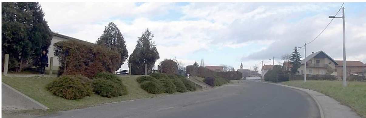
slika 33. ulica Podolnica, pogled od kolnog ulaza prema sjeveru na proširenje za parkiranje automobila uz zapadni rub ulice, bez pješačke staze
