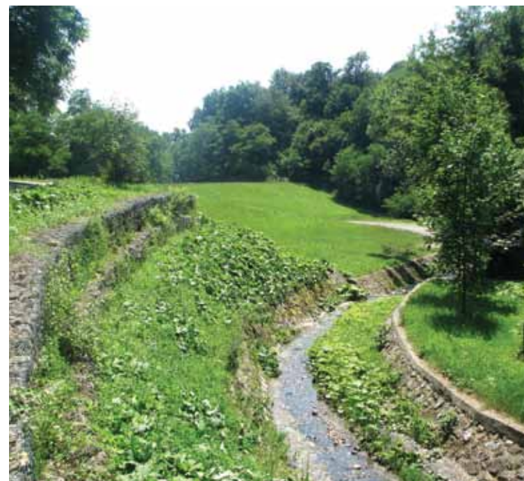
◀ PRIKAZ 37 KANALIZIRANI DIO POTOKA VIDOVEC / CHANNELED PORTION OF VIDOVEC BROOK
