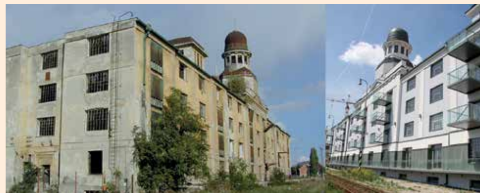
EUROVEA, PREOBRAZBA SKLADIŠTA / EUROVEA, WAREHOUSE CONVERSION
