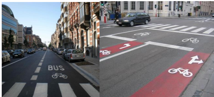
Preporučena traka, autobusno-biciklistička traka, naprijed postavljena zaustavna linija – foto: T. Asperges, D. Dufour
