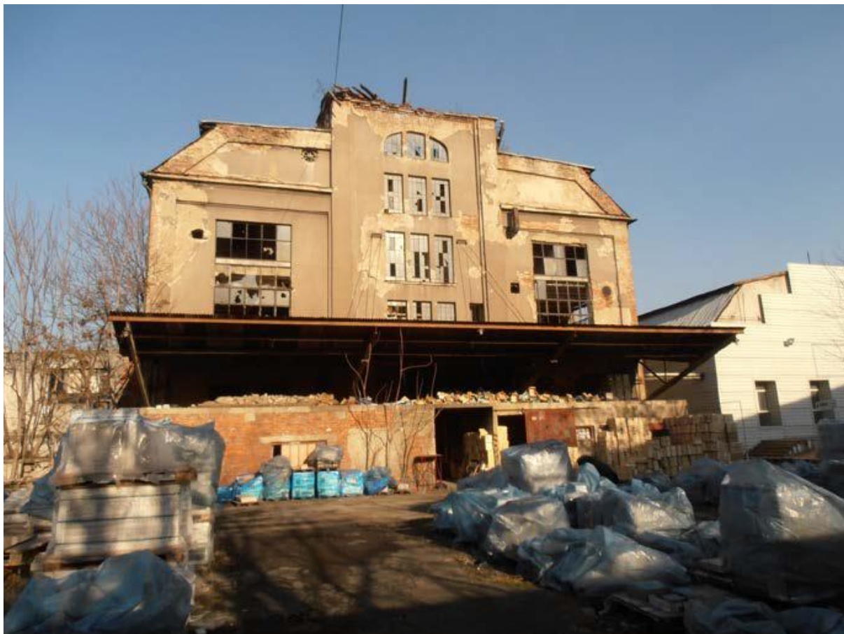
Sl. 13. Južno pročelje tvornice pjenice i dogradnja skladišta u prizemlju
