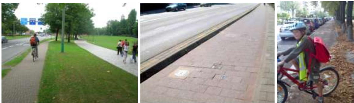
Biciklističke staze odvojene razdjelnim (zelenim) pojasom, rubnjakom, i parkirnom trakom (foto izvor: T. Aspergers, P. Kroeze, D. Dufour)
