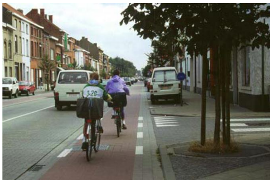
Biciklistička traka na glavnoj cesti presijeca sporednu cestu (foto izvor: Vademecum fietsvoorzieningen, Vlaanderen)
