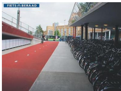
Intermodalna biciklistička stanica u Groningenu; podzemna, ali dobro osvijetljena danjim svjetlom i opremljena prilazima malog nagiba (izvor: Fietsberaad – NL)
