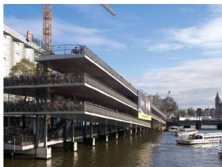
Inovativni „stan“ za bicikle („bicycle flat“) u Amsterdamu, u blizini glavnog kolodvora. Izgrađen je iznad vode (NL)
