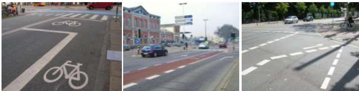
Biciklistička zaustavna linija (Kopenhagen); motorna traka za skretanje udesno, postavljena s lijeve strane biciklističke trake (SIC? Na slici izgleda da je s desne strane ) (Dordrecht); traka za prestrojavanje /čekanje pri skretanju ulijevo / pripremna traka za skretanje ulijevo (Bremen) (foro izvor: F. Boschetti, P. Kroeze)
