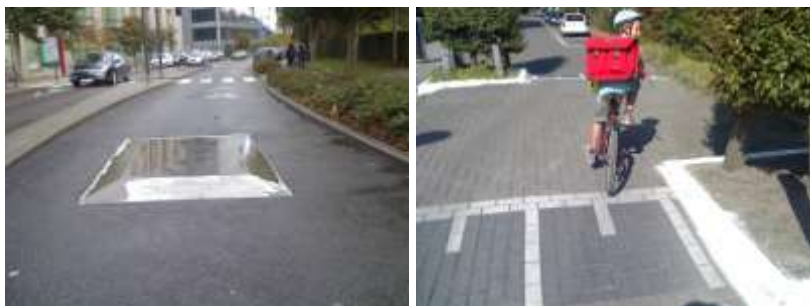
Vertikalne i horizontalne mjere smanjenja brzine prilagođene biciklistima (foto izvor: D. Dufour)
