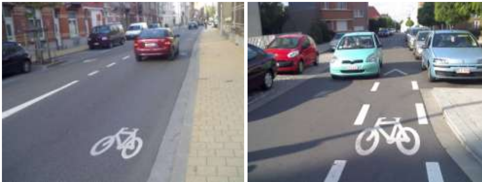
Istosmjerna preporučena traka i preporučena traka suprotnog smjera (foto-izvor D. Dufour)
