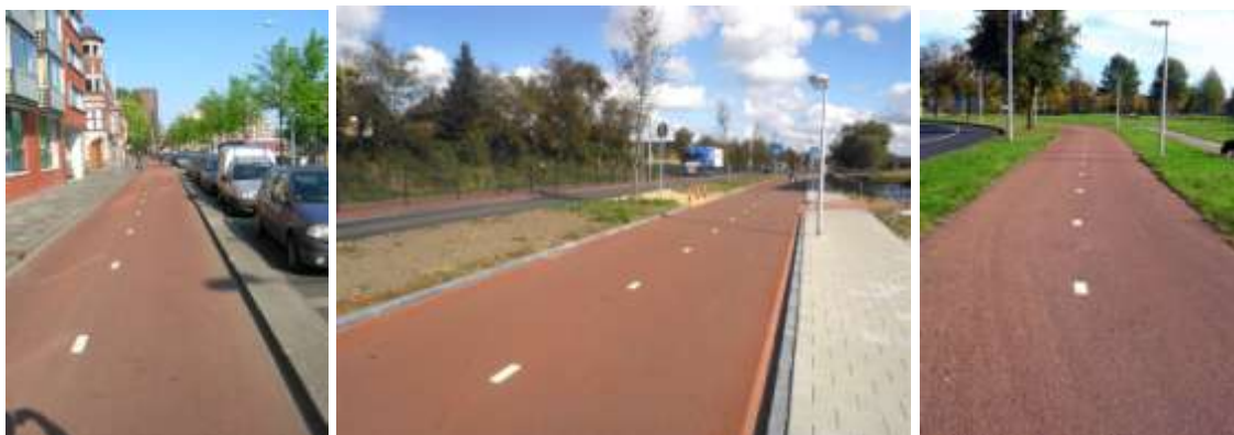
Dvosmjerne biciklističke staze s jedne strane glavne ceste (foto izvor: P. Kroeze)
