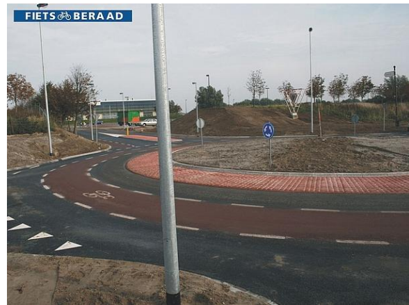
Biciklistička traka označena po sredini kružnog toka (foto izvor: Fietsberaad)
