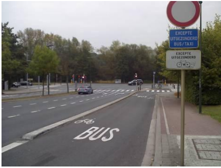
Autobusno-biciklistička traka s obilaskom za desno skretanje (pored semafora), sa zatvorenim profilom i simbolom bicikla na kolniku (D. Dufour)
