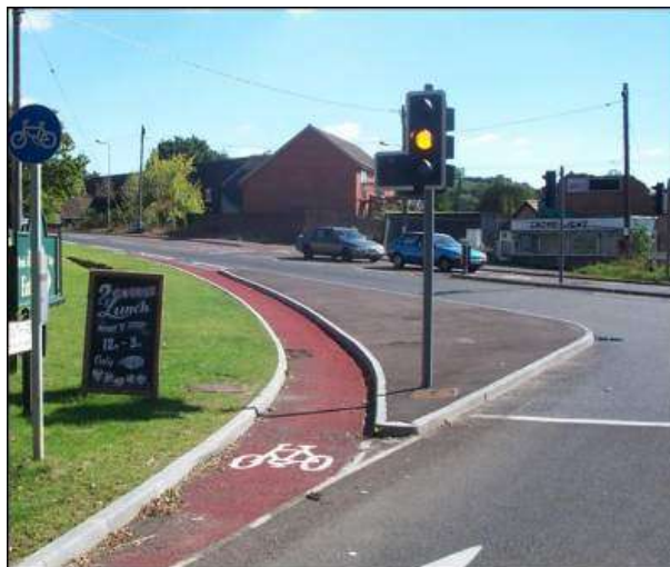
Biciklistička traka za skretanje kroz crveno svjetlo – primjer iz Velike Britanije (skretanje ulijevo). (izvor: Cycling England, Rob Marshall)
