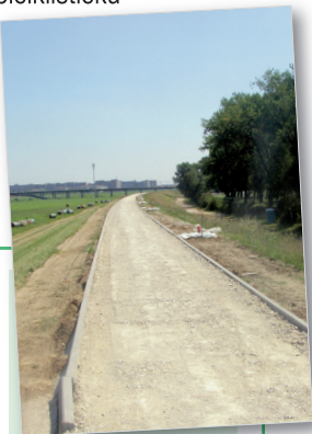
MATERIJAL Staza uz rijeku Savu napravljena je od sitno granuliranog pijeska zbijenog unutar rubnjaka
